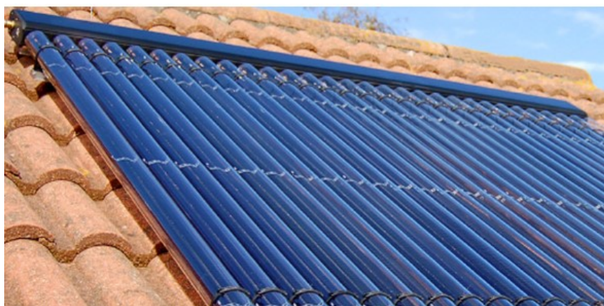
Collettori solari sulla copertura
